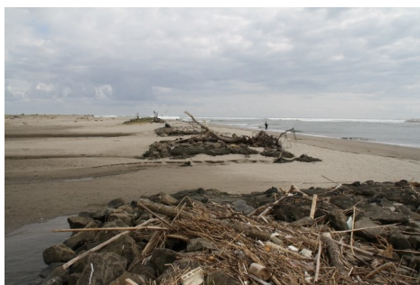
Fig.2 砂に埋もれた導流堤
