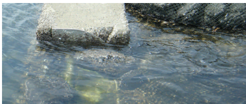
(Fig.5 導流堤の水が出入りする部分)
