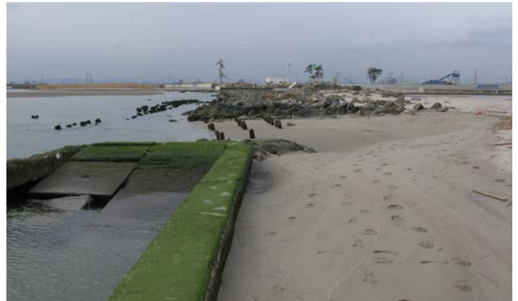
Fig.3 2015年2月11日 調査地点1から西側を望んだところ
