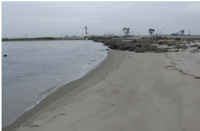
Fig.2 2014年10月2日 調査地点1から西側を望んだところ
