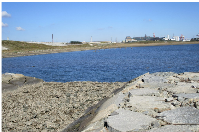
Fig.2 導流堤から干潟中央方向の様子
