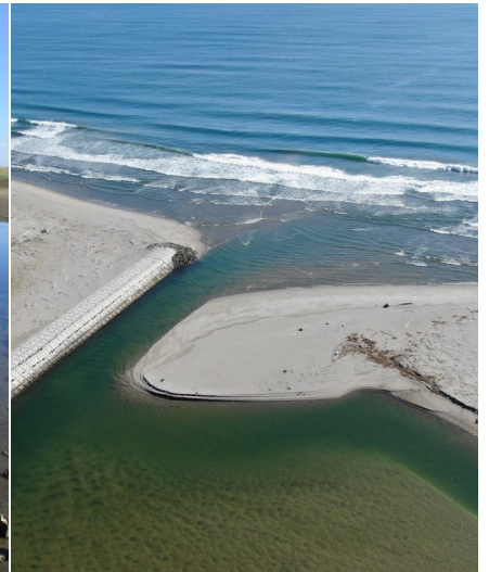
Fig.5 七北田川河口右岸砂州 (ドローン撮影)
