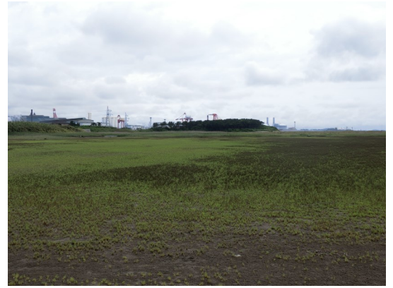
Fig.1 エリアBを南西側から撮影
