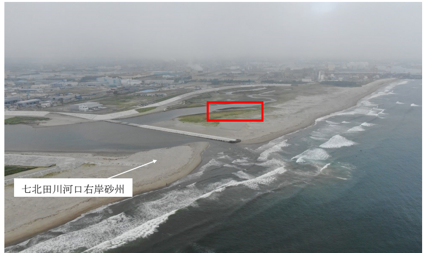
Fig.2 潟湖全体の様子（南東側からドローン撮影）
