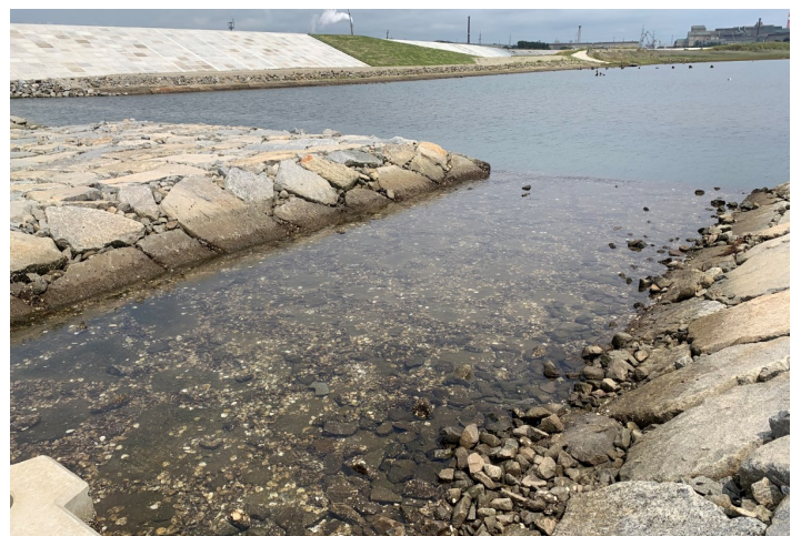
Fig.3 潟湖南部の導流堤通水部ようす
