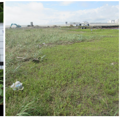
Fig.9 エリアE,Fを北側から撮影
