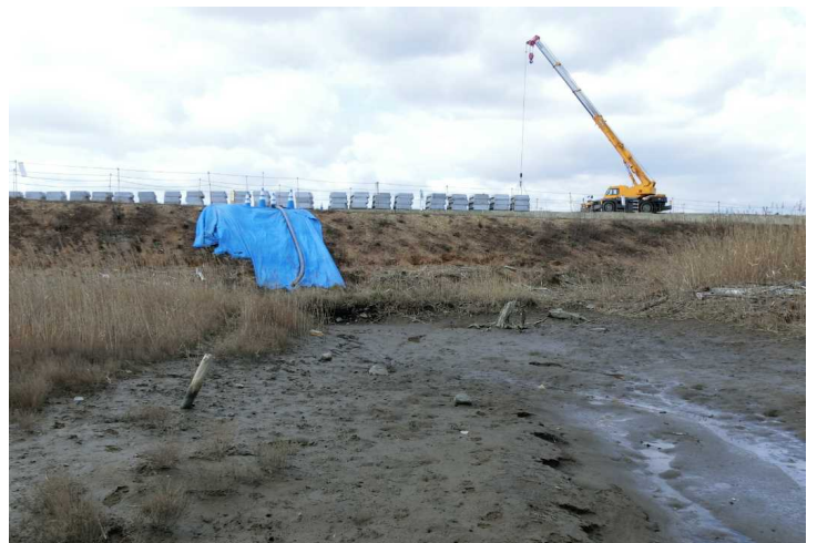
Fig.3 St.6対岸付近の様子
