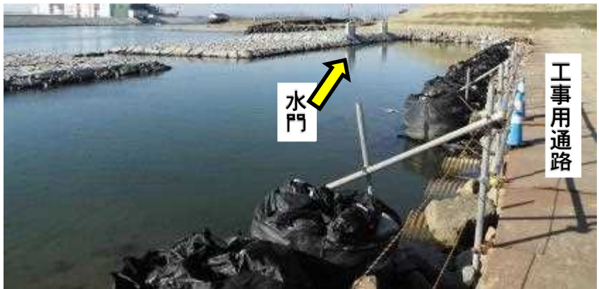
(Fig.2 工事用通路の通水部)
