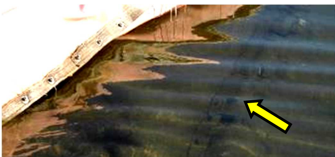
(Fig.5 着底しているオイルフェンス)
