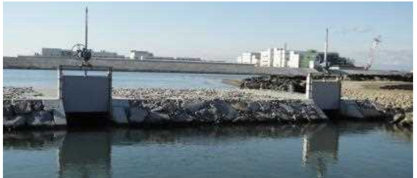
(Fig.1 水の通る水門)
