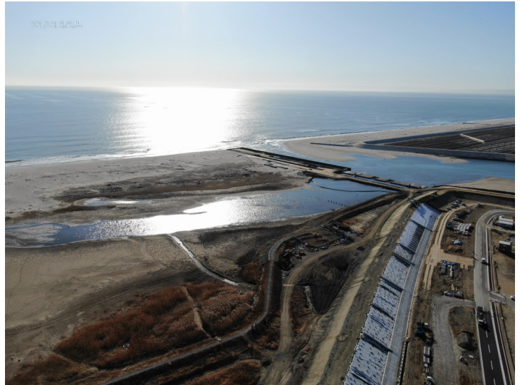
Fig.3 河口付近の砂州の状況(北側上空よりドローン撮影)
