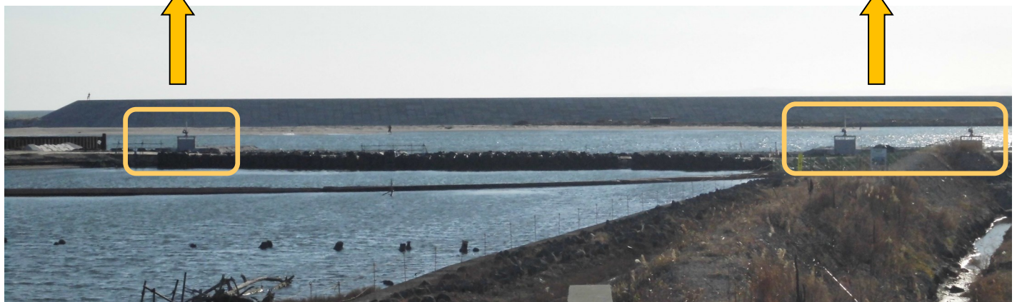
(Fig.1 工事が進む河口の堤防)
