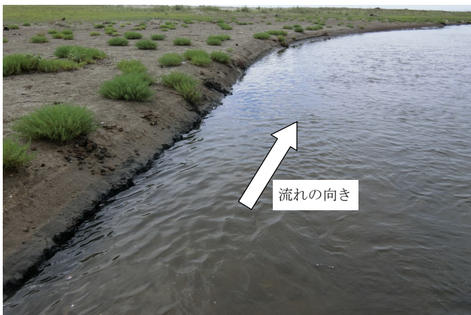
Fig.2 水流により浸食されている(北側より撮影)
