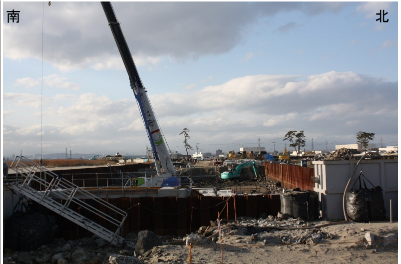
Fig.3 導流堤付近の工事の様子(東側より撮影)
