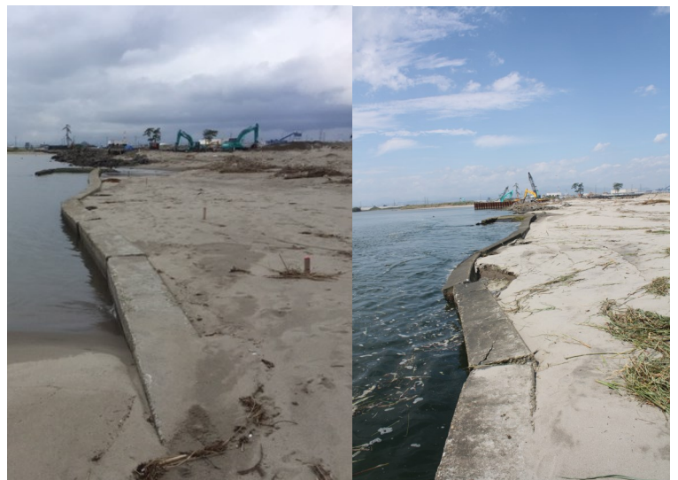
Fig.5 護岸ブロック 左5月撮影 右9月撮影（東側より撮影）
