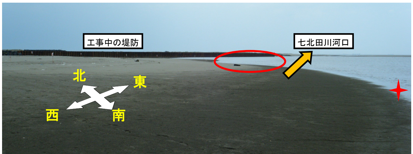
(Fig.1 工事が進む七北田川河口域)
