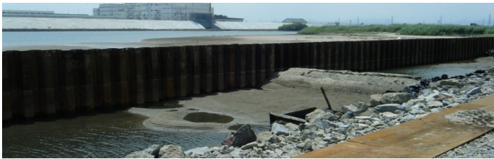
(Fig.1 河口の工事の様子)
