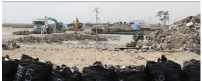
Fig.3 導流堤の工事の様子（東側より撮影）
