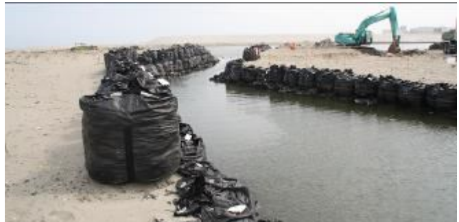
Fig.4 通水した通水部分（北側より撮影）
