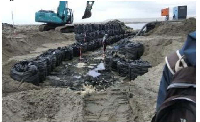
Fig.4 新たに建設中の通水部分詳細（北側より撮影）
