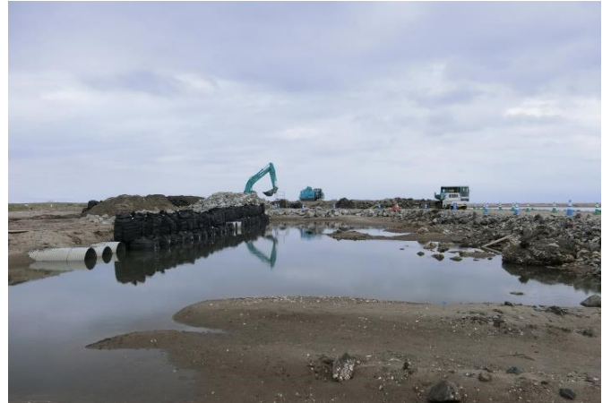
Fig.5 2つの通水部分の間のようなす（西側より撮影）
