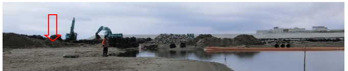
Fig.3 新たに建設中の通水部分全景（北側より撮影）
