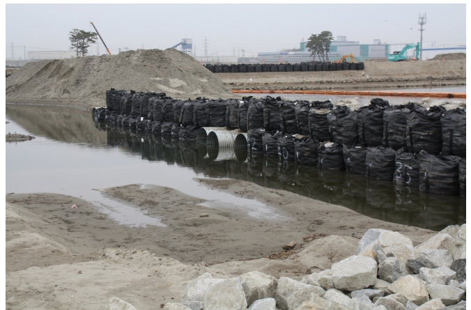
Fig.3 新たに作られた銀色の通水部分（南側より撮影）
