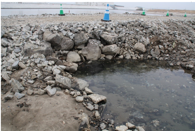
Fig.2 黒色のパイプの通水部分（北側より撮影）
