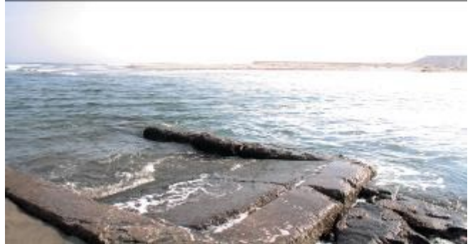
Fig.4 侵食により砂州が縮小した右岸（北側より撮影）
