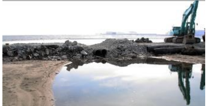
Fig.3 導流堤通水部分の工事の様子
