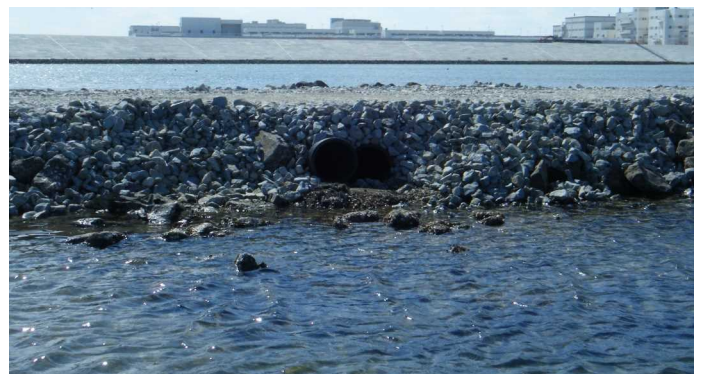
(Fig.3 工事中の導流堤)
