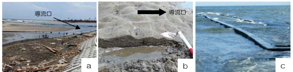
Fig.2 当日の画像 a:導流口付近に発達する砂州 b:潟湖底面のカレントリップル c:海中に没した導流堤（写真の位置はfig.1のa~c）
