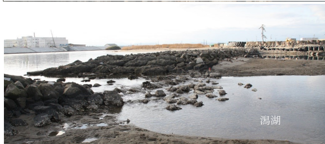
Fig.3 中央通水部分のようす（東側より撮影）
