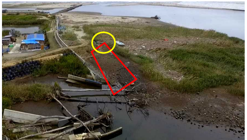
(Fig.1 七北田川河口 水門付近 2016年12月撮影)
