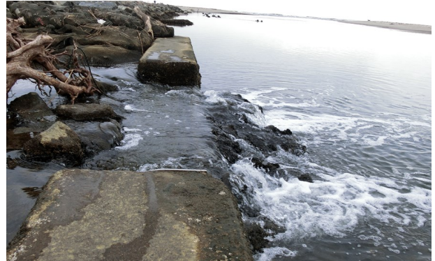
Fig.4 東側通水部の様子（西側から撮影）
