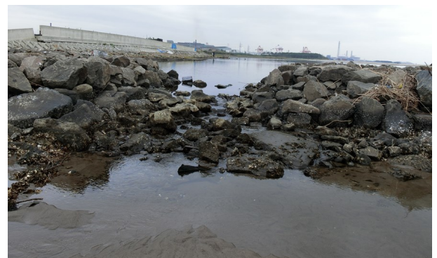
Fig.6 西側通水部の様子（南側から撮影）
