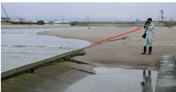
Fig.3 護岸ブロックに積もった砂（東側から撮影）
