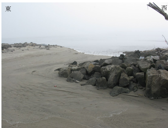
Fig.2 満潮時には通水していない 東側通水部分
