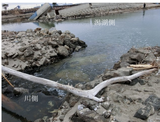
Fig.2 新たに工事された導流堤通水部分
