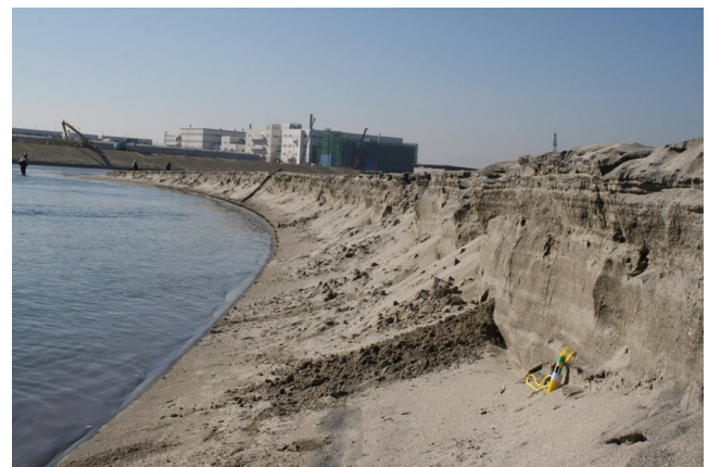
Fig.3 導流堤の南側に1m以上の高さに堆積した砂
