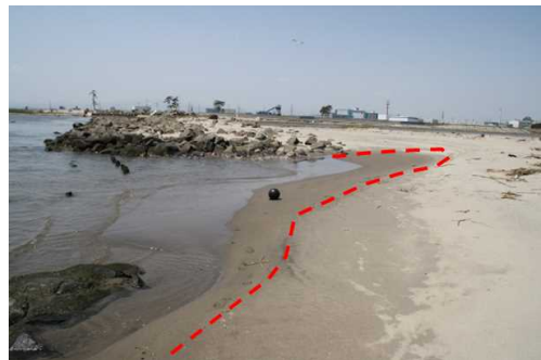
Fig.3 護岸ブロックと導流堤の間に流れ込む水 東側から撮影
