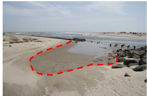
Fig.2 護岸ブロックと導流堤の間に流れ込む水 西側から撮影
