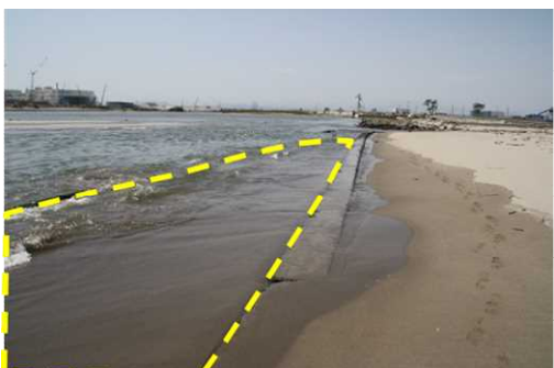
Fig.4 2つの護岸ブロックの間に堆積した砂
