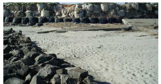
(Fig.3 砂が堆積した導流堤基部)
