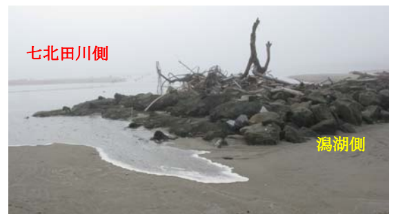
Fig.2 東側の導流堤通水部から流入しているようす
